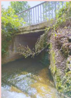
Cadre béton non-enterré sous passage routier
