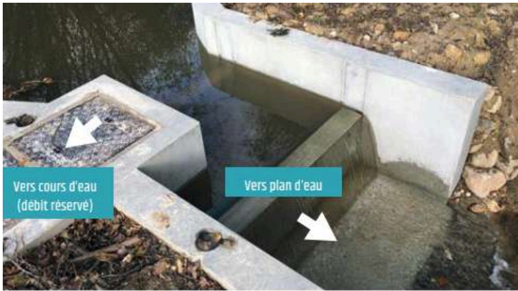
EXEMPLE D'OUVRAGE RÉPARTITEUR SUR UN PLAN D'EAU DU BASSIN DE LA SERÈNE (LA FOUILLADE)
