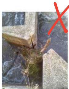
Encombrement d'une entrée hydraulique et d'une échancrure interbassins
