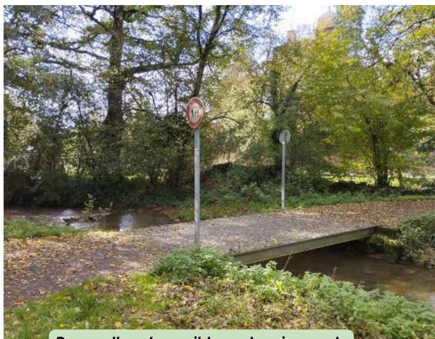
Passerelle submersible sur le ruisseau de Fontanges (Rodez Agglomération)
