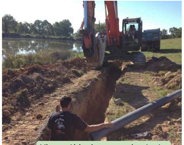
Mise en dérivation souterraine du plan d'eau de Cavagnal (La Fouillade)
