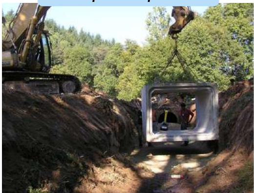
Mise en place du pont cadre
