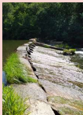
Déversoir latéral de moulin
