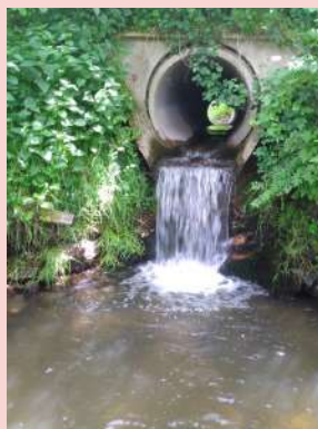
Buse sous chemin
