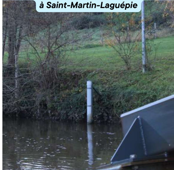
Sonde mise en place pour connaître le niveau d'eau de la retenue amont sur la microcentrale hydroélectrique du Parrinet à Saint-Martin-Laguépie
