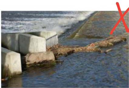
Encombrement d'une entrée hydraulique et d'une échancrure interbassins
