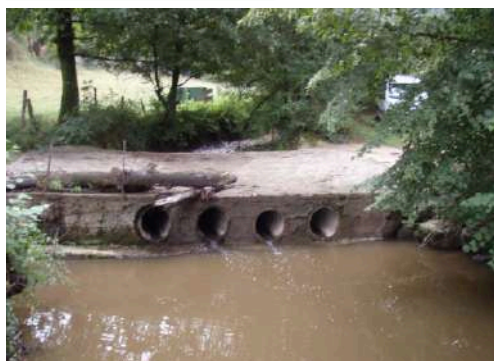
Suppression de passages busés sur l'Alzou en 2009 au profit d'un passage à gué (communes de Rignac et Roussennac)
