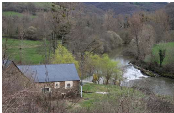
Centrale hydroélectrique - moulin de Fans
