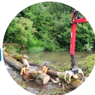
Enlèvement des embâcles après un épisode de crue
