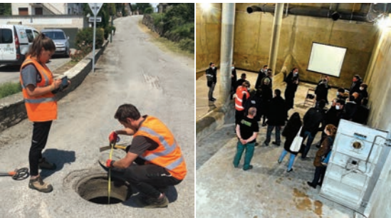
Étude réseaux, La Fouillade. Inauguration du bassin d'orage de l'Auterne, Rodez.
