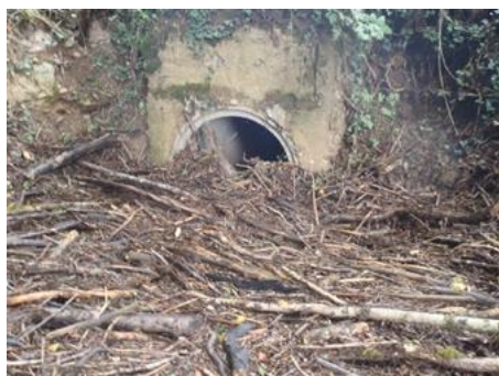
Figure 50 : Photos illustrant à droite l'obstruction d'un passage busé par des rémanents e à droite une coupe forestière dans la forêt des Palanges (PPG HVA 2014)
