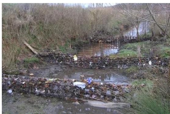
Figure 39 : Photo d'un "dégrilleur artisanal" installé en sortie d'un exutoire pluvial sur le ruisseau de l'Auterne afin de piéger une partie des déchets
