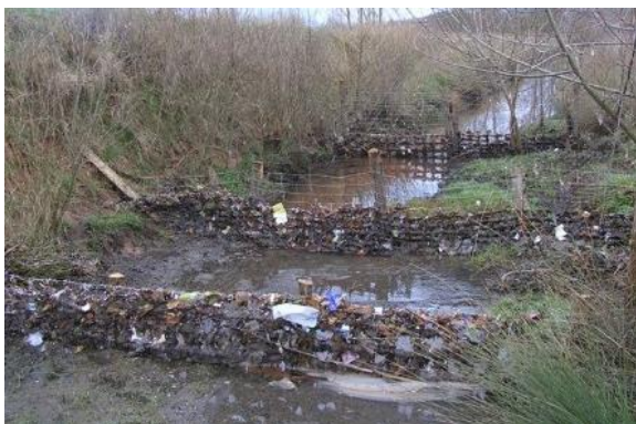
Figure 38 : Photo d'un "dégrilleur artisanal" installé en sortie d'un exutoire pluvial sur le ruisseau de l'Auterne afin de piéger une partie des déchets
