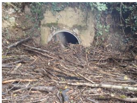
Figure 49 : Photos illustrant à droite l'obstruction d'un passage busé par des rémanents et à gauche une coupe forestière dans la forêt des Palanges (PPG HVA 2014)
