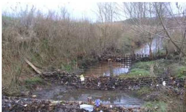
Photo d'un "dégrilleur artisanal" installé en sortie d'un exutoire pluvial sur le ruisseau du l'Auterne afin de piéger une partie des déchets
