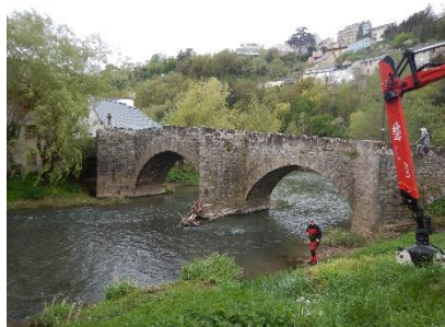
Intervention en traversée urbaine – Rodez Agglomération
