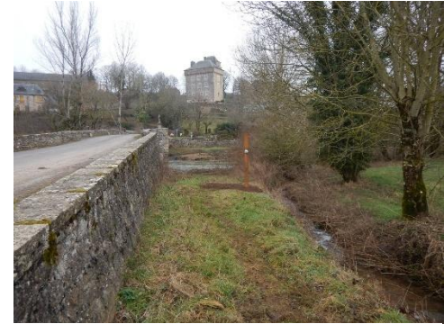
Repères de crues - Comtal Lot Truyère
