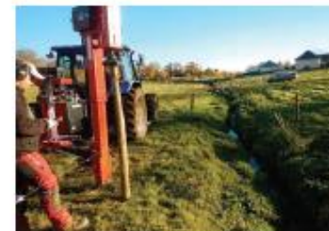
Mise en œuvre de clôtures sur la Briannelle, Flavès.
