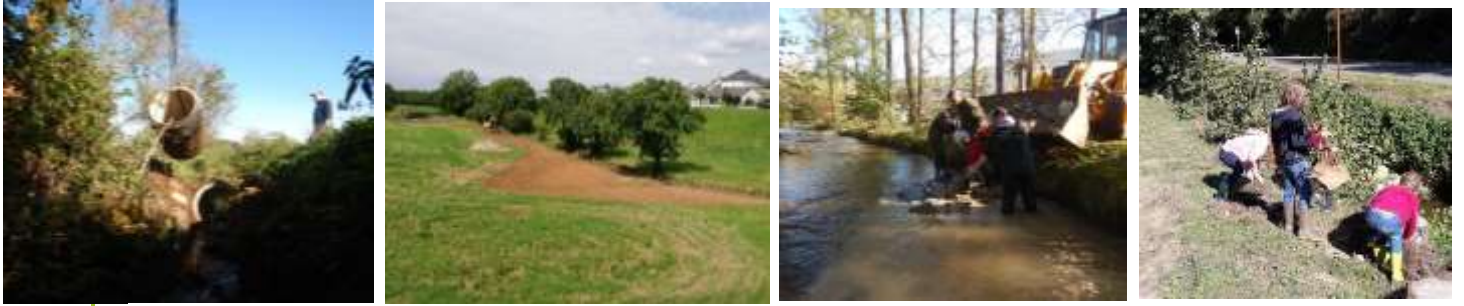
Illustration de travaux de renaturation :
