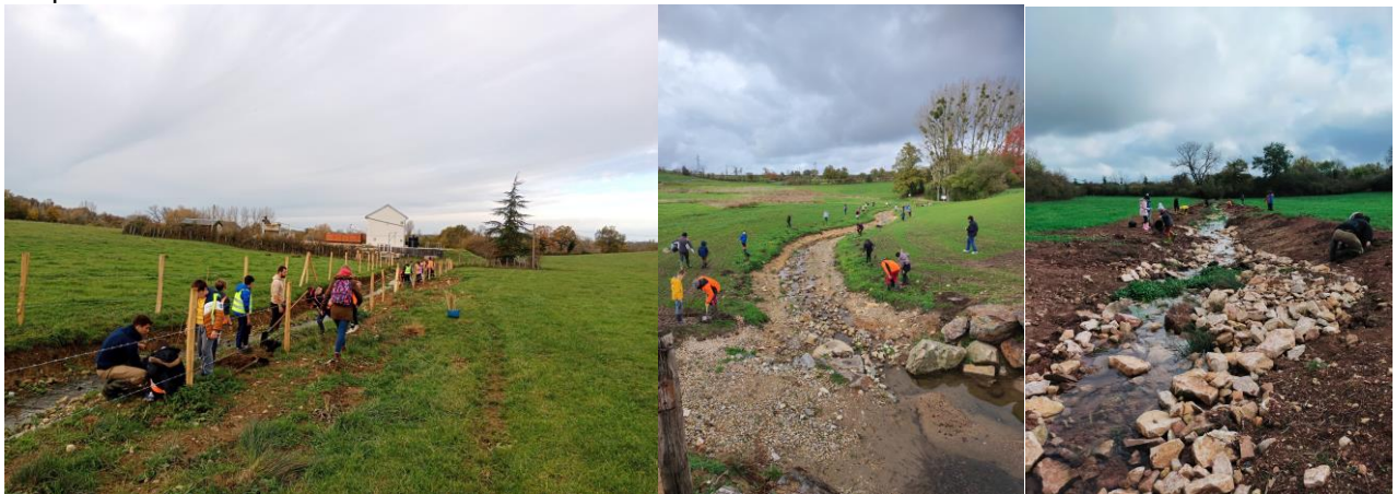
Illustration de travaux de renaturation : Reprofilage, méandrage, diversification des écoulements, plantations et pose de clôtures en contexte d'élevage Action MAPPG-6
