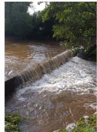
Passage busé des Calquières
