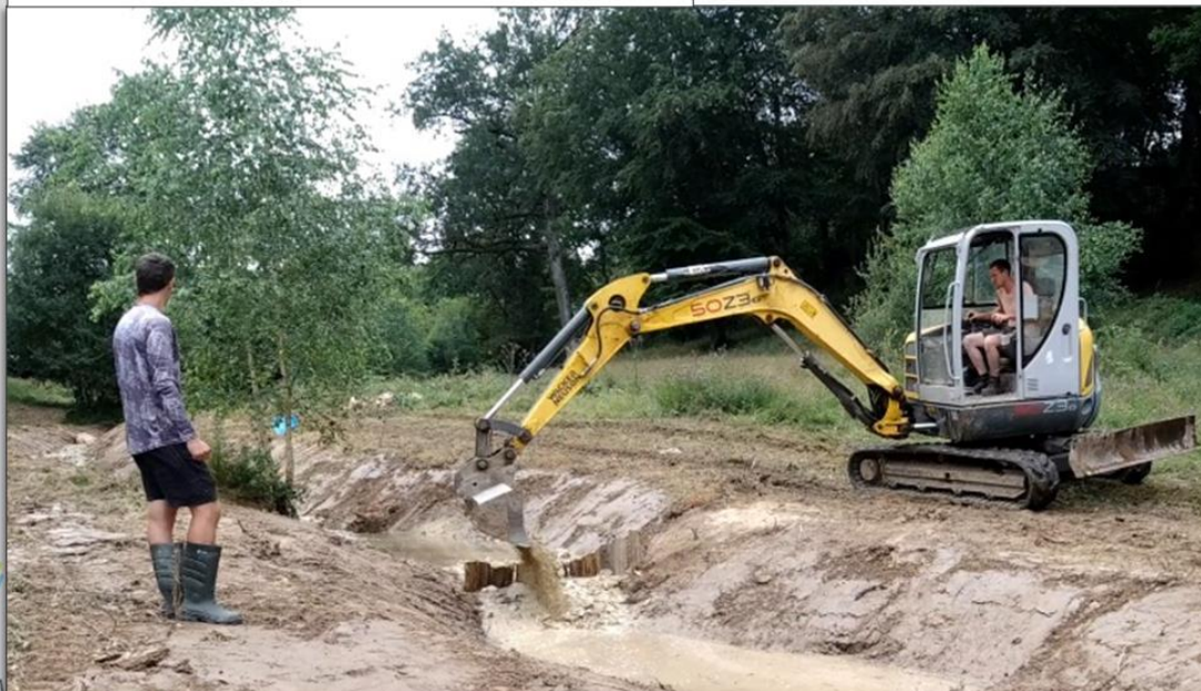
Recharge sédimentaire pour recréer des habitats disparus, augmenter l'autoépuration de l'eau et limiter son réchauffement
