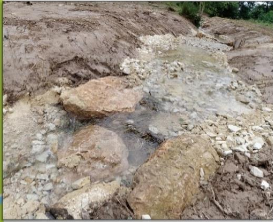
Micro seuils en blocs et en pieux pour rehausser le niveau d'eau et éviter l'incision après chantier
