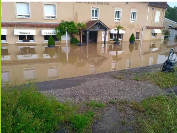
Photo n°1 : Crue soudaine de l'Agouse avec inondation du Relai de Farrou
