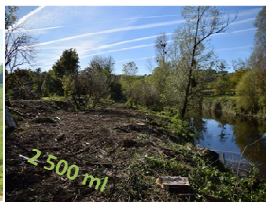
Traitement de la ripisylve - Abattage et remplacement de peupliers
