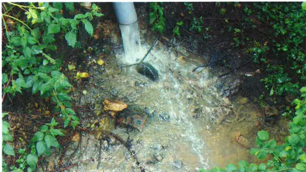
Photos n°12 : rejet dans le ruisseau de La Fouillade issu du by-pass de la station d'épuration, en lien avec une surcharge hydraulique en entrée de station (période pluvieuse – printemps 2017)
