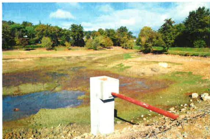
Photo n°4 : installation d'un moine hydraulique sur le plan d'eau de Saubayre (La Fouillade – octobre 2017)
