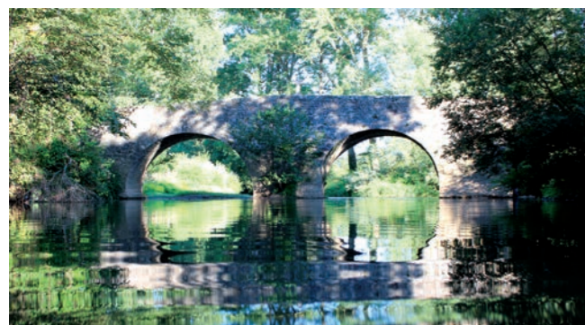
Pont de Montrozier, entre Gages et Bertholène.
